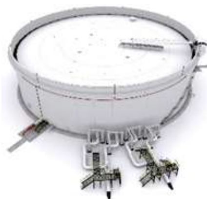
Резервуар вертикальный стальной с плавающей крышей (РВСПК)
